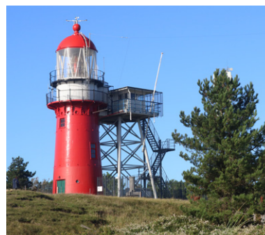
Vuurtoren, uitkijklokaal en brandtrap.
