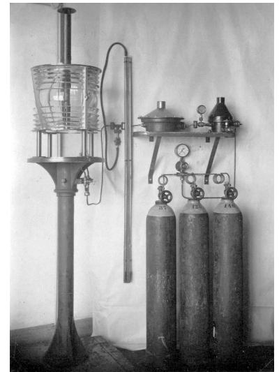
De optiek van Kraggenburg die voor 1940 dienst deed. Rechts de gascilinders voor de voeding van het gloeilicht.
