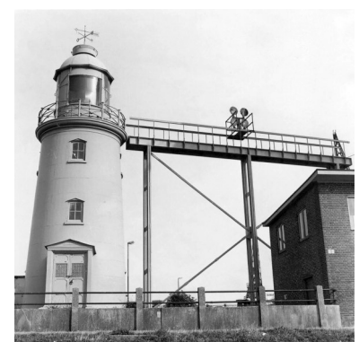
In 1967 is het licht in de gietijzeren toren gedoofd en hebben drie schijnwerpers op een stelling naast de toren de functie van het lage licht overgenomen. De foto dateert van 1973.
