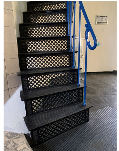
De originele gietijzeren wenteltrap.
