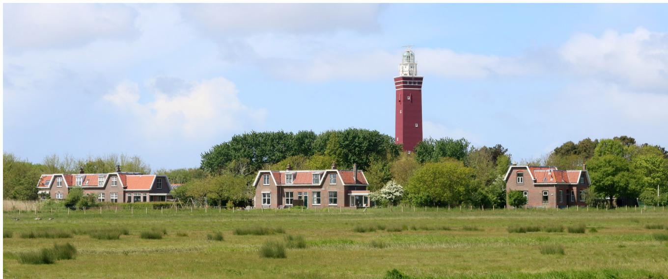
De lichtwachterswoningen uit 1912 worden nu particulier bewoond.
