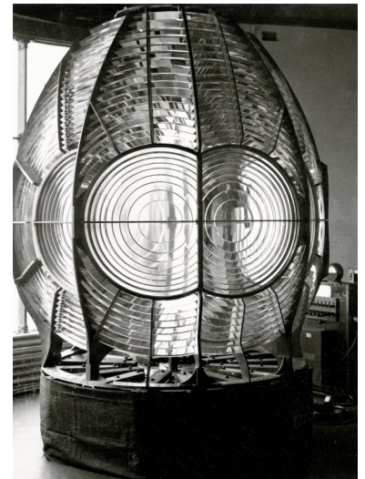
De nieuwe optiek voor de Lange Jaap, opgesteld in het proefstation in Scheveningen in 1949.
