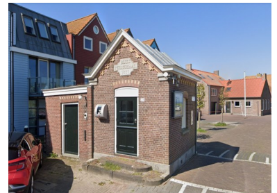
Het in 1880 gebouwde peilschaalhuis aan de Havenweg.
