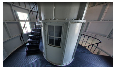
Het interieur van de Buitentoren, met centrale schacht, gietijzeren vloeren en gietijzeren trappen.
