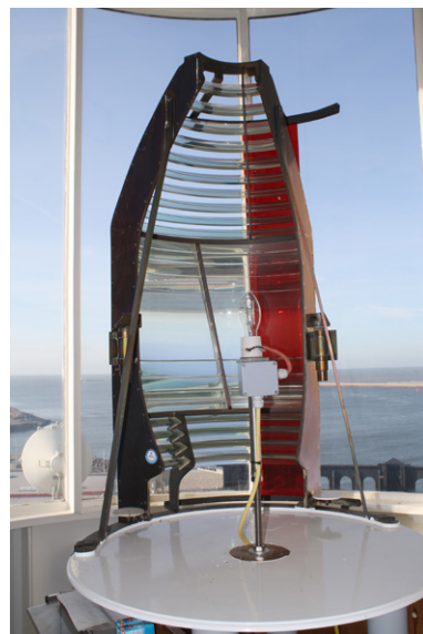
De in 1950 geplaatste optiek, een lens-paneel van de derde grootte, geleverd door Chance Brothers uit Birmingham, met een halogeenlamp van 500 watt als lichtbron. Deze is in 2025 vervangen door een ledarmatuur.
