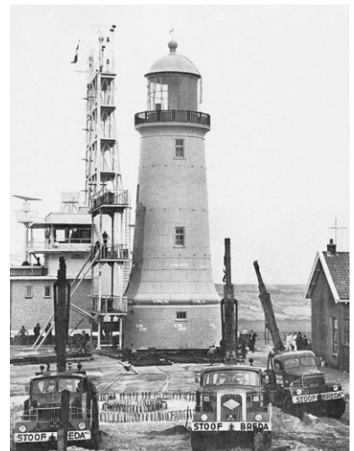
Mammoettransportbedrijf Stoof is bezig met de verplaatsing van de Buitentoren.
