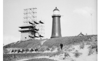
Tijdens de Tweede Wereldoorlog moest de semafoor plaatsmaken voor een Duitse bunker. Op het restant van de bunker werd een nieuwe semafoor gebouwd. Op deze foto uit 1948 is hij nog in aanbouw.
