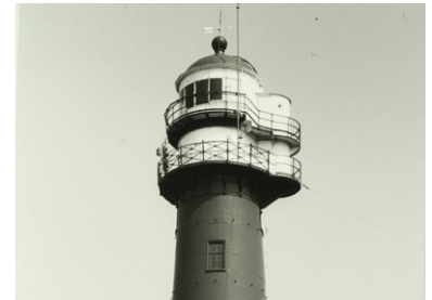
De kop van de vuurtoren in 1986. De uitbouw van de omloop is nog aanwezig.
