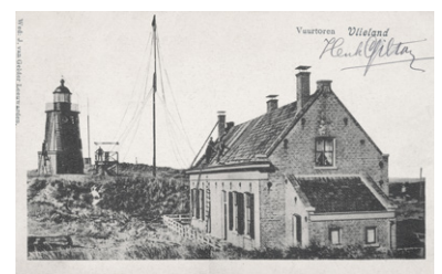
De stenen vuurtoren en de lichtwachterswoningen omstreeks 1900.
