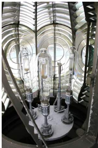
De optiek van het hoge licht van Hoek van Holland uit 1960, in de vuurtoren op de Maasvlakte Bron: https://kustverlichtingsmuseumhoekvanholland.nl/het-hoge-licht-van-de-uitgaande-lichtenlijn/
