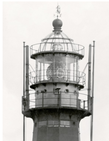
In 1922 kreeg de vuurtoren een nieuwe scheepvaartoptiek, een luchtvaartoptiek en een glazen koepel met een extra omloop.
