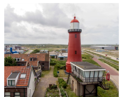
Een foto uit 2013, met op de voorgrond de seinpoststelling, zonder de seininstallatie.
