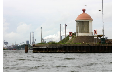
Het in 1989 verwijderde lighthouse van de buitentoren aan de kop van de Derde Rijksbinnenhaven in Velsen-Noord
