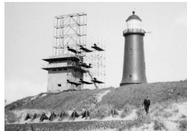
Tijdens de Tweede Wereldoorlog moest de semafoor plaatsmaken voor een Duitse bunker. Op het restant van de bunker werd een nieuwe semafoor gebouwd. Op deze foto uit 1948 is hij nog in aanbouw.
