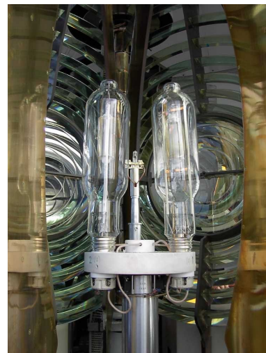
Lampenwisselaar met kwikjodidelampen.
