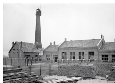
De vuurtoren, de nieuwe machinekamer en opzichterswoning in 1917.
