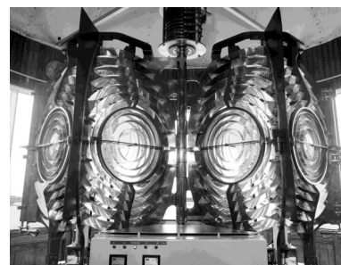
De dubbeloptiek van het hoge licht uit 1909.
