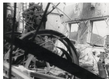
De in 1943 gebombardeerde machinekamer.
