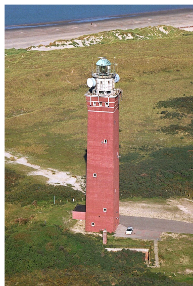
De vuurtoren in 1999. Op de voorgrond is de kelder ('bunker') nog goed te zien. Tegenwoordig is die door de begroeiing vrijwel onzichtbaar. Het schoorsteentje verraadt zijn aanwezigheid. De trommels (straalantennes) onder het lichthuis zijn er nu niet meer.
