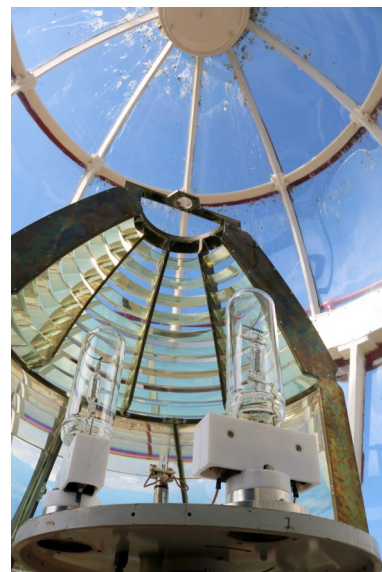
De lampenwisselaar uit 1981 met halogeenlampen.
