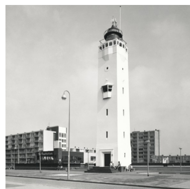
De vuurtoren in 1976, gezien vanaf de Koningin Wilhelmina Boulevard.
