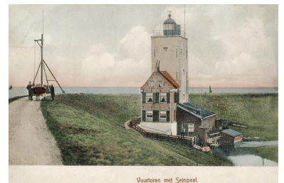
De vuurtoren omstreeks 1907. Op de dijk heeft van 1896 tot 1922 een stormseinpaal gestaan.
