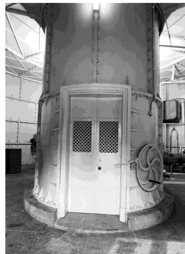
De binnenschacht van de toren in 1976.
