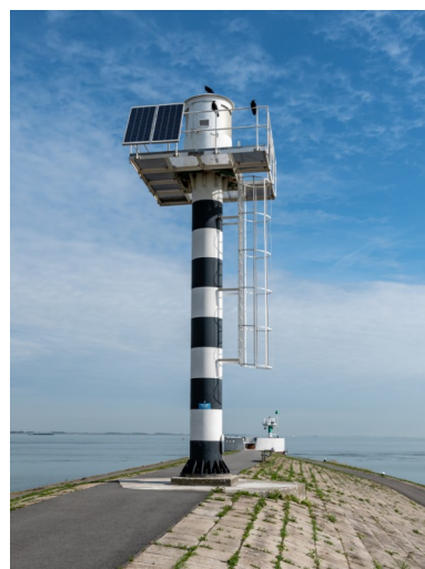
Het sectorlicht op de Westerhavendam van Terneuzen. Het lichthuis is afkomstig van de oude gietijzeren lichtopstand.
