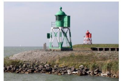
Vlak voor het groene havenlicht staat een rolpaal. De rolpalen op beide havenhoofden werden geplaatst tijdens de aanleg van de haven in 1883-1885.
