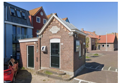
Het in 1880 gebouwde peilschaalhuis aan de Havenweg.
