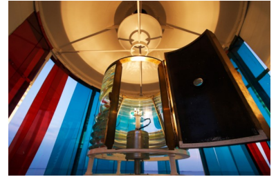
De trommeloptiek en sectoren in 2013, vlak voordat deze werden verwijderd.
