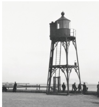
Het havenlicht in 1913. De kleine lantaarn werd in 1907 vervangen door een groter lichthuis met tochtportaal.
