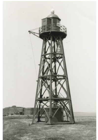
De vuurtoren van Den Oever in 1974, met tochtportaal op de omloop en een hijsinrichting voor stormseinen.
