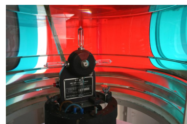
De lampenwisselaar met halogeenlampjes in 2006.
