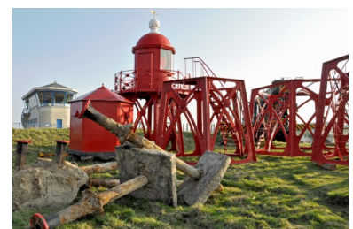
De aparte onderdelen van de vuurtoren en de oude funderingspalen op 16 maart 2017.
