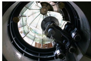
De optiek van de Maasvlakte van onderaf gezien, met zicht op de aandrijfmotor en de lampenwisselaar. Deze zijn inmiddels verdwenen, alleen de optiek is er nog.
