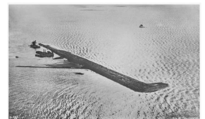
Aanleg Wieringermeerdijk op de zandplaat Oude Zeug, 18 februari 1928.
