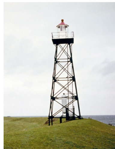
De originele lichtopstand Zeughoek op de Wieringermeerdijk in 1971.
