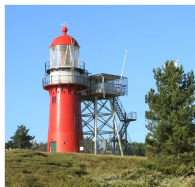
Vuurtoren, uitkijklokaal en brandtrap.
