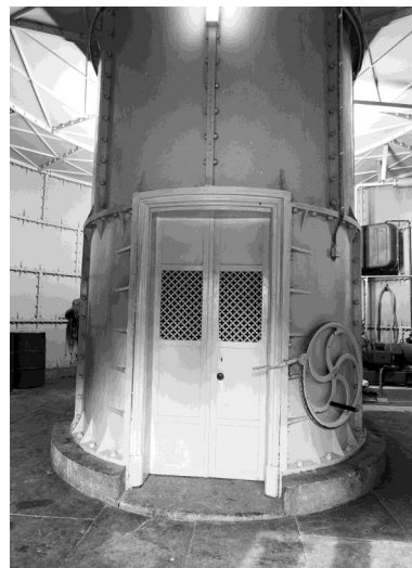
De binnenschacht van de toren in 1976.
