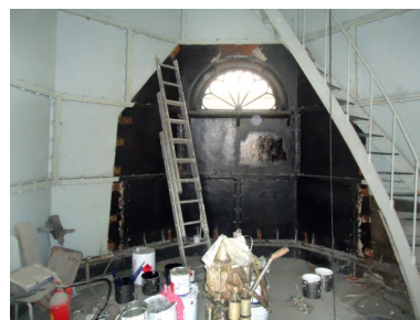
Renovatie van het interieur, 19 september 2014.
