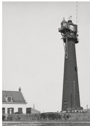
Tijdens de verbouwing in 1912, met een hulplicht op een houten onderstel.
