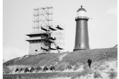
Tijdens de Tweede Wereldoorlog moest de semafoor plaatsmaken voor een Duitse bunker. Op het restant van de bunker werd een nieuwe semafoor gebouwd. Op deze foto uit 1948 is hij nog in aanbouw.
