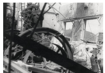
De in 1943 gebombardeerde machinekamer.
