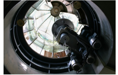
De optiek van de Maasvlakte van onderaf gezien, met zicht op de aandrijftafel en de lampvenwisselaar. Deze lampvenwisselaar is inmiddels verdwenen.
