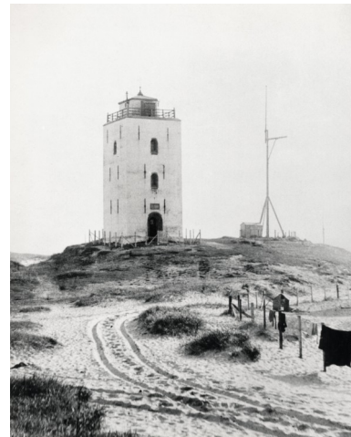
De vuurbaak vlak na de restauratie van 1901, waarbij er een nieuwe mantel om de toren werd gebouwd.
