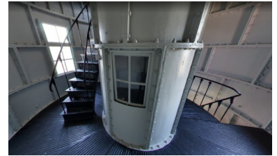
Het interieur van de Buitentoren, met centrale schacht, gietijzeren vloeren en gietijzeren trappen.
