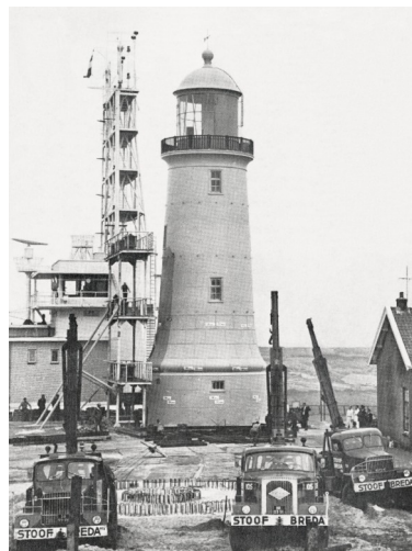
Mammoettransportbedrijf Stoof is bezig met de verplaatsing van de Buitentoren.
