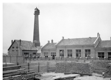
De vuurtoren, de nieuwe machinekamer en opzichterswoning in 1917.
