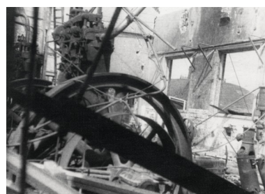
De in 1943 gebombardeerde machinekamer.
