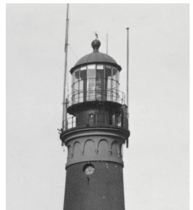
De in 1907 geplaatste lantaarn en lantaarnkuip.
