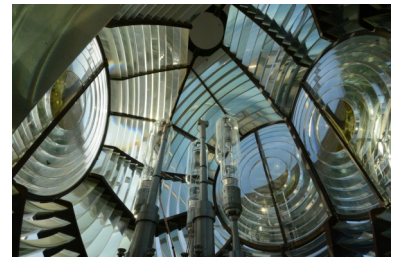
De optiek van 1950, met een moderne lampenwisselaar met kwikjodidelampen.
