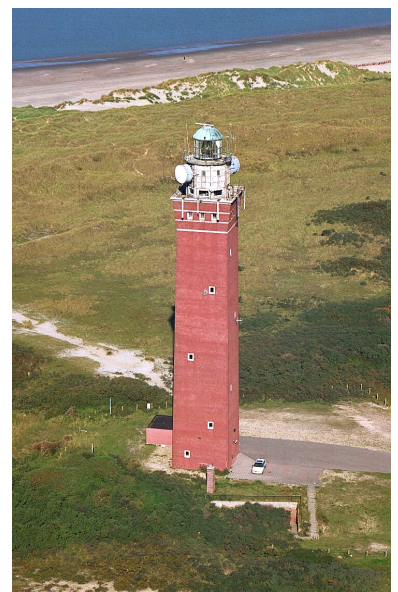
De vuurtoren in 1999. Op de voorgrond is de kelder ('bunker') nog goed te zien. Tegenwoordig is die door de begroeiing vrijwel onzichtbaar. Het schoorsteentje verraad zijn aanwezigheid. De trommels (straalantennes) onder het lichthuis zijn er nu niet meer.
