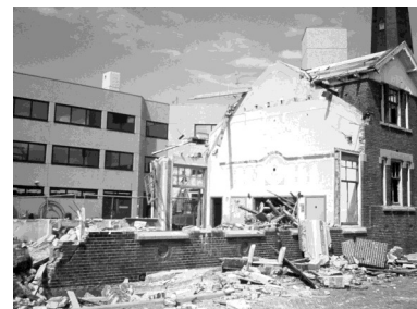
Afbraak van het proefstation en nieuwbouw van het Loodswezen in 1977.
