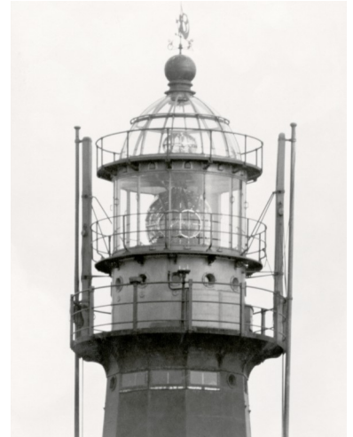
In 1922 kreeg de vuurtoren een nieuwe scheepvaartoptiek, een luchtvaartoptiek en een glazen koepel met een extra omloop.
