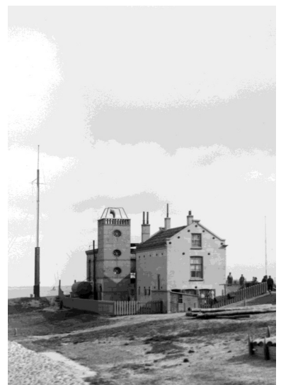
De woning van de machinist met daarachter het vergrote machinegebouw omstreeks 1913.
