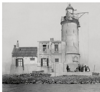
De vuurtoren begin jaren '20, met de in 1918 gerealiseerde motorkamer.
