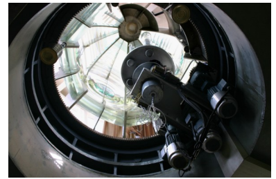
De optiek van de Maasvlakte van onderaf gezien, met zicht op de aandrijftafel en de lampverwisselaar. Deze lampverwisselaar is inmiddels verdwenen.
