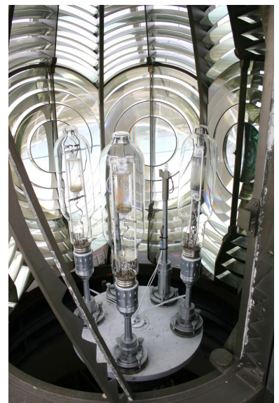
De oorspronkelijke optiek van het hoge licht van Hoek van Holland in de vuurtoren op de Maasvlakte. De foto dateert van 2004, toen de toren nog actief was.
